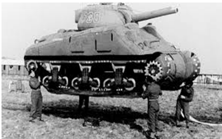
Tanque inflável utilizado para confundir os aviões de reconhecimento alemães antes do Dia D
